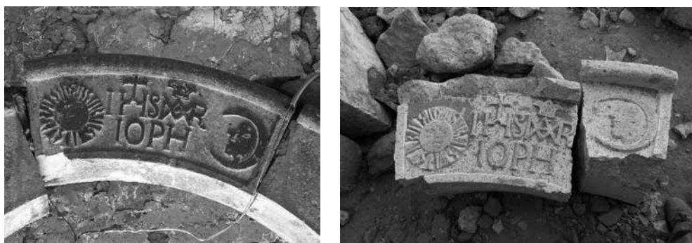
Figura 4.1 y 4.2: Arco central de la Iglesia de Sotoca, con el monograma IHS, Jesús salvador de los hombres y María Reina, antes (izquierda) y después (derecha) del terremoto de 2005 que afectó la zona norte de Chile (Fotografías: Panorámico Iglesia Sotoca, Ángela Benavente y Carolina Ossa) 36
